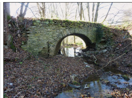
Kamenný most na cestě směrem k Hvozdečku
