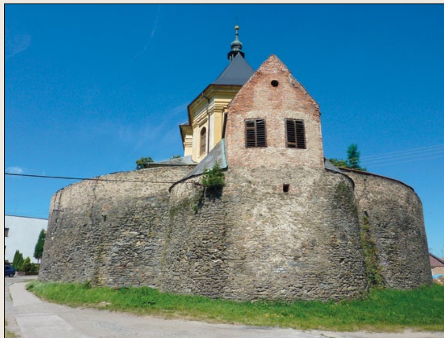
Opevnění kostela sv. Jiří v Nákle: pohled na budovu márnice s opěrnou zdí.
