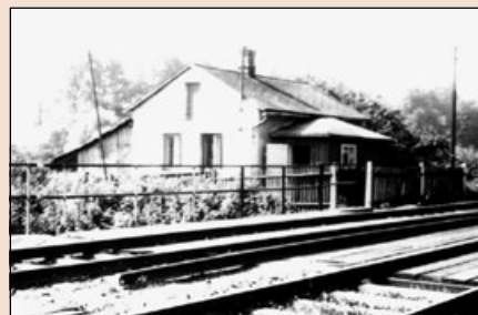
Strážní domek na dráze ve Studénce, foto, 1955. Soukromá sbírka V. Langera, Koprivnice.
