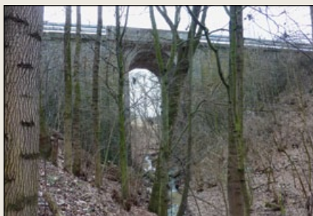
Kamenný vysoce klenutý most č. III.
