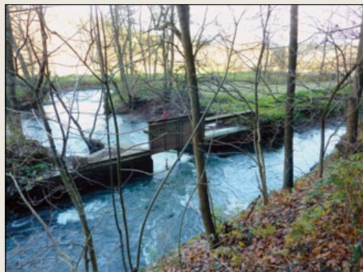
Doly: jez se stavidlem na Třebůvce.
