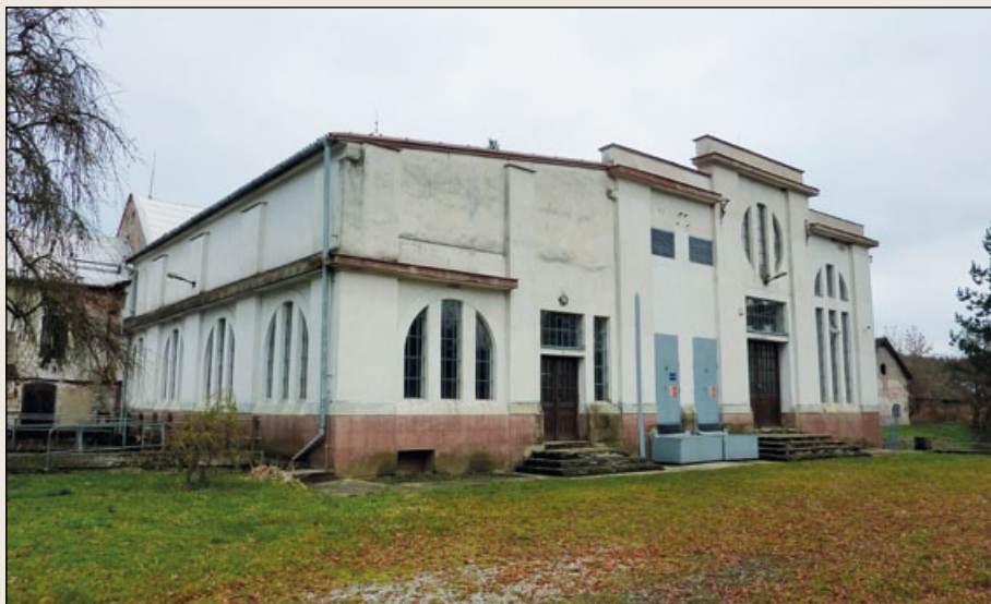
Řimice – Nové Mlýny: budova elektrárny.
