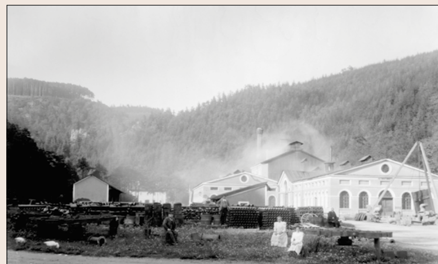
Starohraběcí huť byla uvedena do provozu v roce 1835. Při peci byla postavena kuplovna. Litina a litinové součásti proslavily železářny po celém světě.
