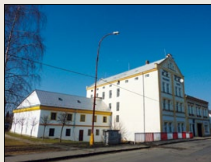
Litovel – Plíškův mlýn: celkový pohled.
