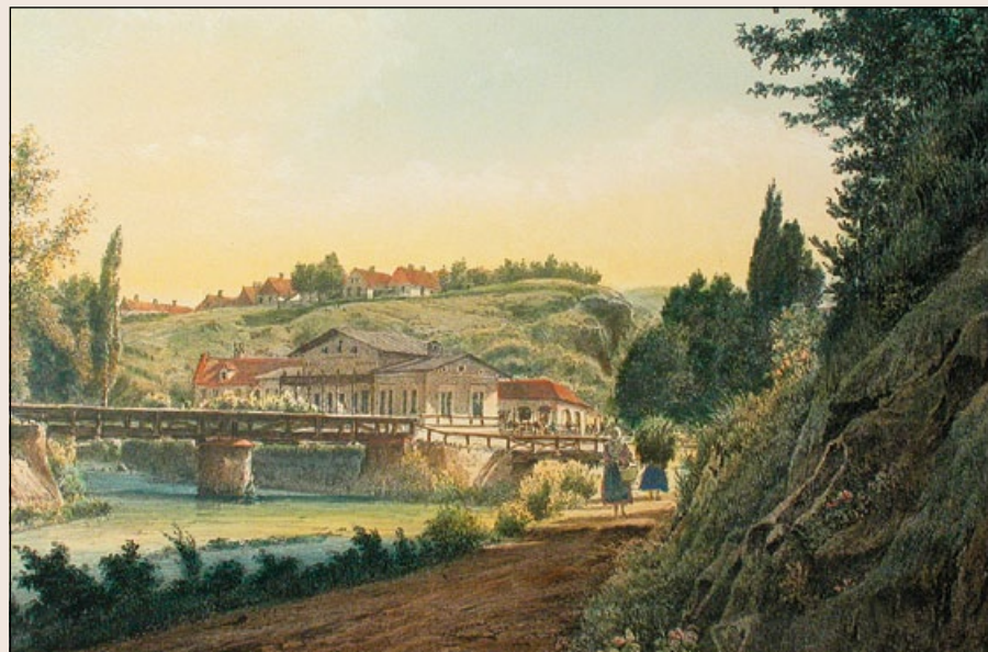
Závodní restaurace železáren stávala u soutoku Punkvy se Svitavou nedaleko Mariánské huti.
