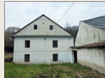
Kozov: celkový pohled na mlýn.
