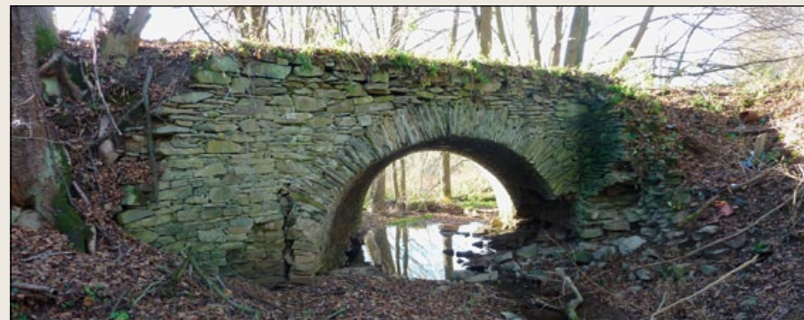
Středověká cesta u Bouzova: starý kamenný most nad údolím směrem k Hvozdečku (od jihu).
