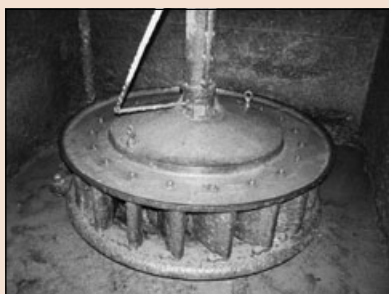
Francisova turbína při vypuštění vody ve mlýně v Bartošovicích, foto. Soukromá sbírka V. Máchy, Bartošovice.
