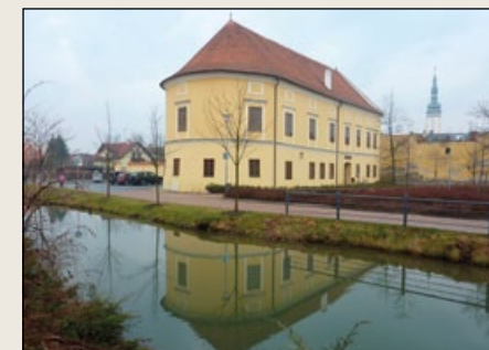
Městské hradby v Litovli: bývalá městská střelnice, dnes městské muzeum.
