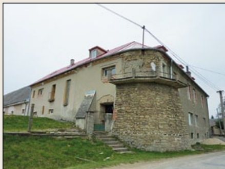
Tvrz Podolí: pohled na rohový pilíř.
