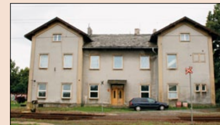
Bývalé místní nádraží směr Štramberk ve Studénce, foto LA, 2011.
