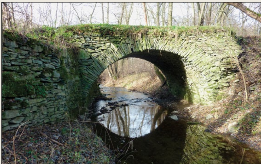
Středověká cesta u Bouzova: starý kamenný most nad Javoříčkou.
