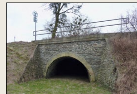
Kamenný klenutý most č. I u motorestu.
