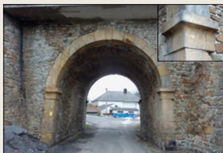
Most č. IX v Měníku a detail mostu s osazením.
