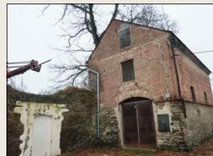
Městské hradby v Litovli: stará ledárna k uskladnění ledu vytěženého z rybníků.
