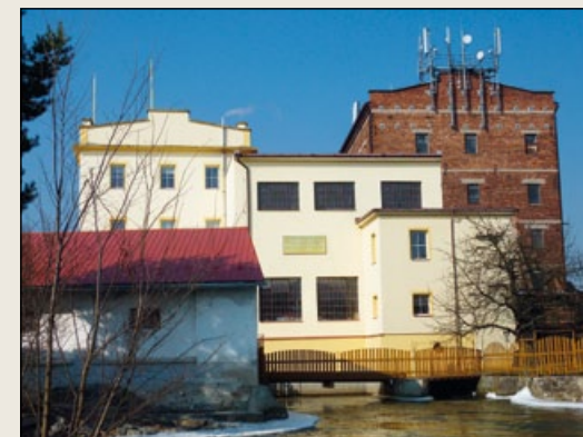
Horka nad Moravou: pohled na vodní elektrárnu.
