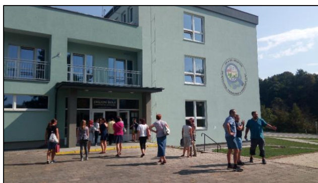
Budova ZŠ Hradišín
