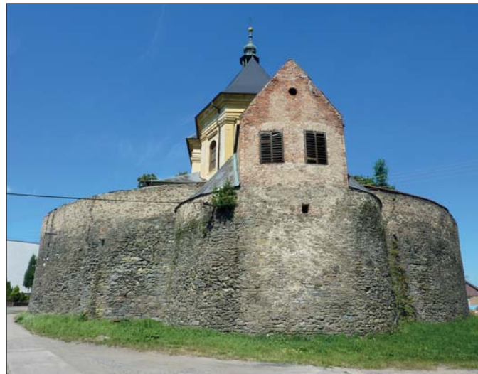
Tvrz Unčovice – Pohled na vstup do areálu tvrze
