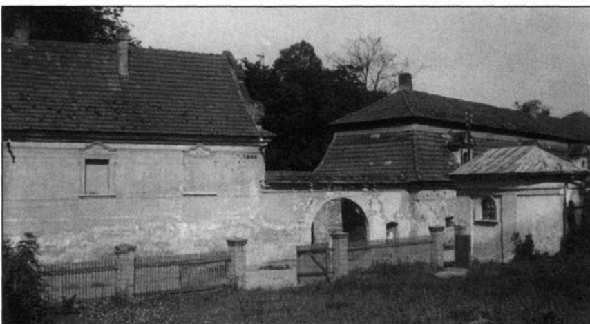
Použití mansardové konstrukce střechy na jednom z hospodářských křídel zámku (foto 1956)
