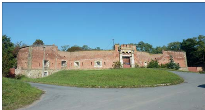
Fort č. XX. v Křelově – Celkový pohled na fort z týlové strany
